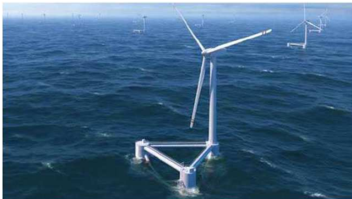
Figure 5 : Eolienne flottante à plateforme semi-submergée (source : energiesdelamer.blogspot.com )
