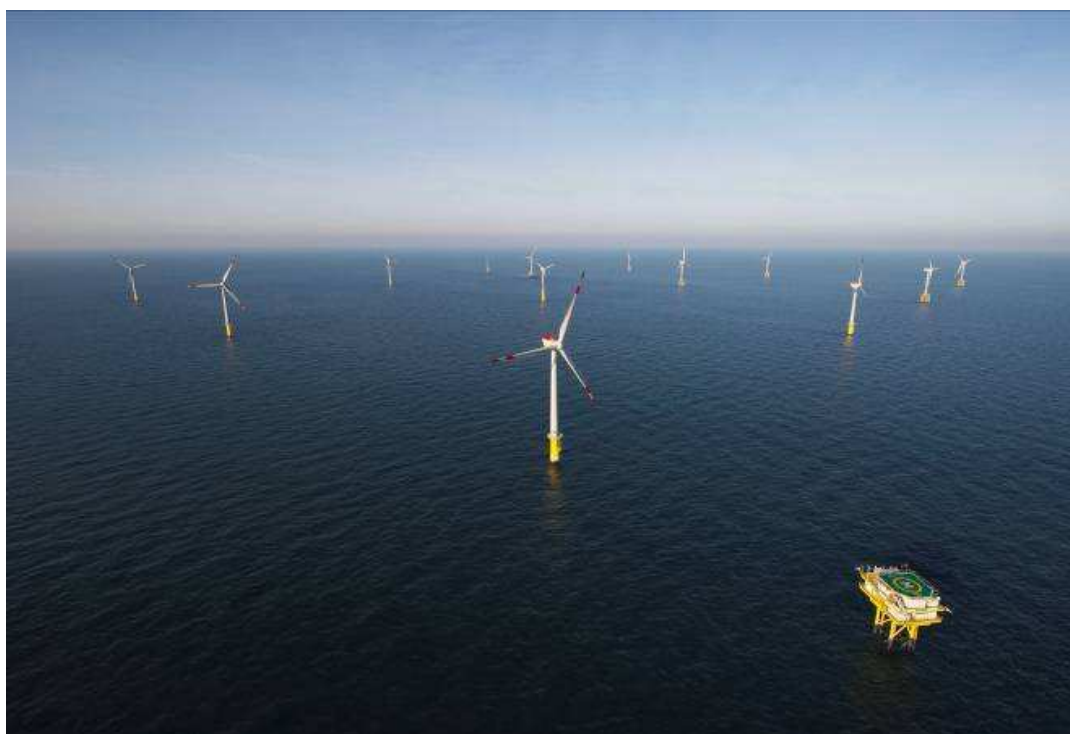
Figure 3 : Eoliennes en mer posées. Parc d'Alpha Ventus en Allemagne (source : Adwen [anciennement Areva Wind])
