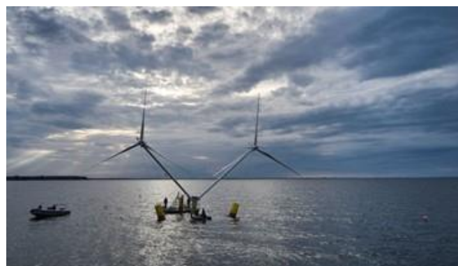
Figure 2: Le prototype 1 :10 Nezy 2 installé par EnBW (source : EnBW)
