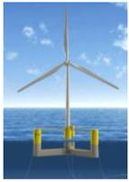
Le projet consiste en une seule plate-forme flottante en béton semi-submersible qui soutiendra une éolienne commerciale de 10 à 12 MW, **une première aux États-Unis**.
