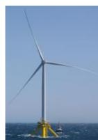
L'éolienne fournie par Siemens Gamesa Renewable Energy de 3,6 MW a été installée sur site avec le concours de la société française Bourbon Subsea Services en **septembre 2021**. La disposition modulaire de la plate-forme flottante se compose d'une structure principale tubulaire en acier avec une quille suspendue. Ce projet s'inscrit dans le cadre d'une coopération entre Shell, RWE Renewables et Stiesdal Offshore Technologies.
