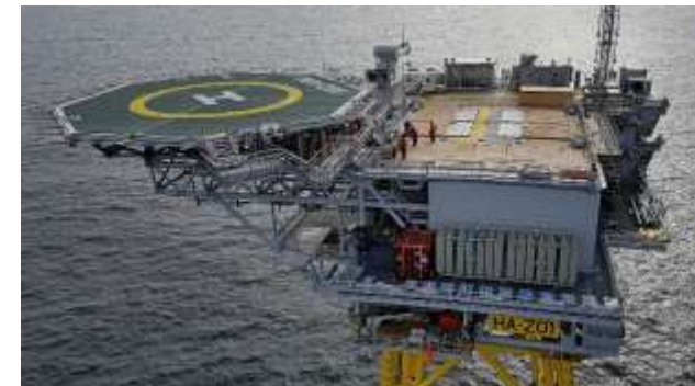
Poste de compensation intermédiaire en mer (Hornsea)
